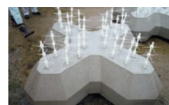
植食性魚類の食害防御材を取り付けたエックスブロック
