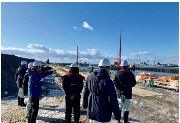
作業所内部監査
