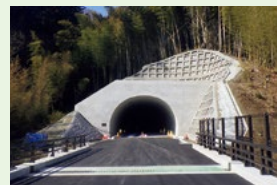
国道349号 丸森第2トンネル工事
