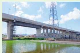
北陸新幹線、福井大町高架橋
