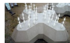
植食性魚類の食害防御材を取り付けたエックスブロック
