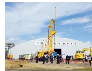
実際の施工機を用いた実験状況
