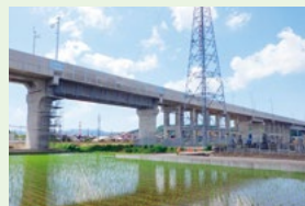
北陸新幹線、福井大町高架橋
