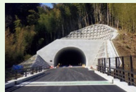
国道349号 丸森第2トンネル工事
