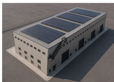
工場棟屋上にソーラーパネル積載
