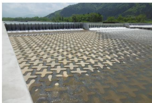
事業主体:国土交通省東北地方整備局 施工場所:秋田県湯沢市
