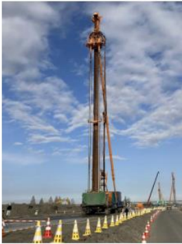
「荒川第二調節池地盤改良工事その1」における施工状況
