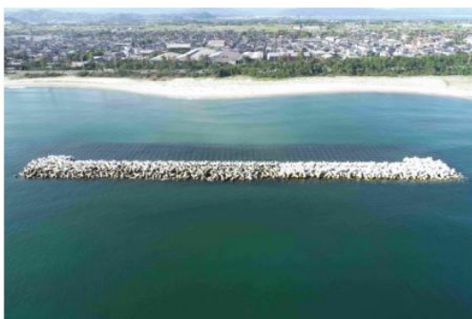
事業主体:国土交通省中国地方整備局 施工場所:鳥取県米子市
