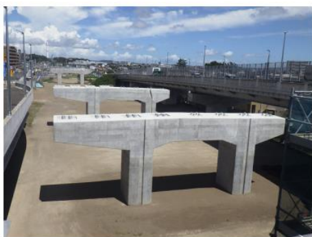
事業主体:国土交通省関東地方整備局 施工場所:神奈川県藤沢市
