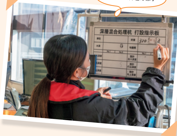
打設中 施工深度管理の様子
