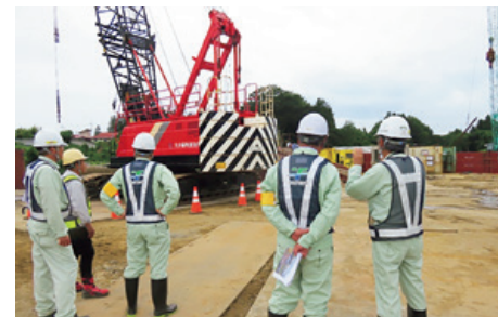
安全衛生パトロール
