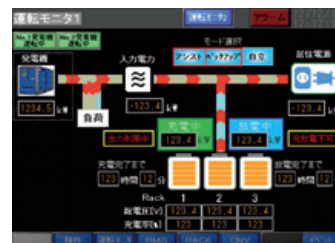
蓄電システム画面
