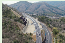
令和3年度東広島バイパス瀬野西IC第4改良工事
