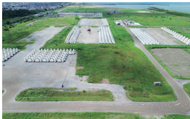
金沢港(大野地区)防波堤(西)(改良)消波・被覆工事(その1)ドロスII 65t型
