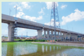
北陸新幹線、福井大町高架橋
