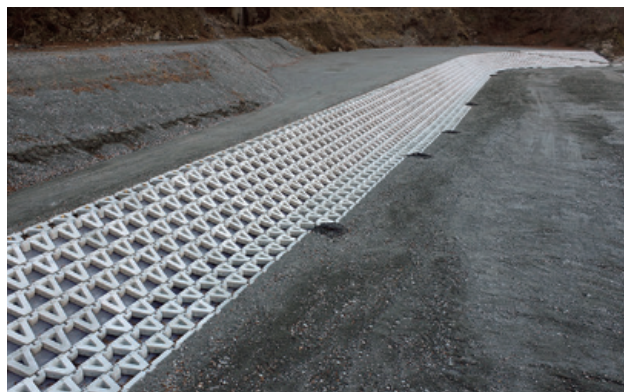
令和6年度 小渋ダム松除地区掘削工事(トリオン標準型)
