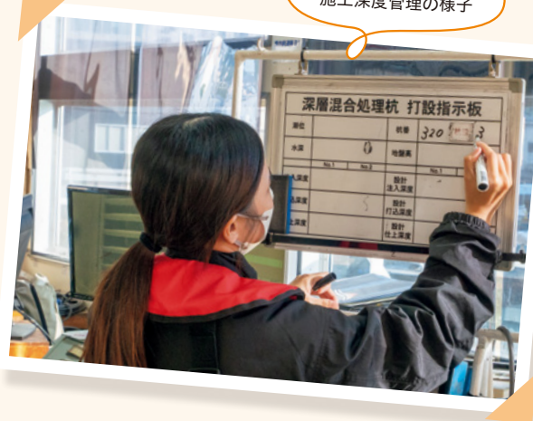
打設中 施工深度管理の様子
