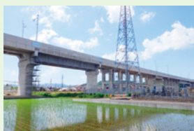
北陸新幹線、福井大町高架橋
