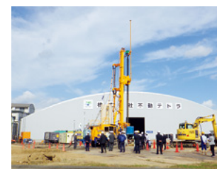
実際の施工機を用いた実験状況
