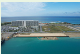
令和4年度糸満地区岸壁(-7.0m)本体工事
