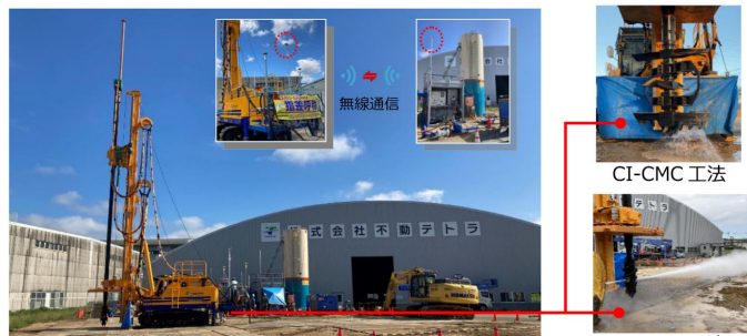
GeoPilot®-AutoPile 小型施工機タイプ
