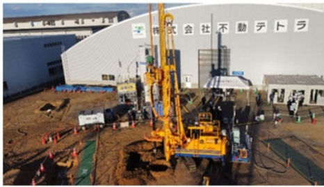
国土交通省「建設機械施工の自動化・遠隔化技術に係る現場検証」の実施状況
