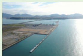
令和3年度下関港(新港地区)岸壁(-12m)築造工事
