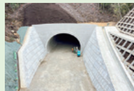
平成31年度 設楽ダム瀬戸設楽線5号トンネル工事
