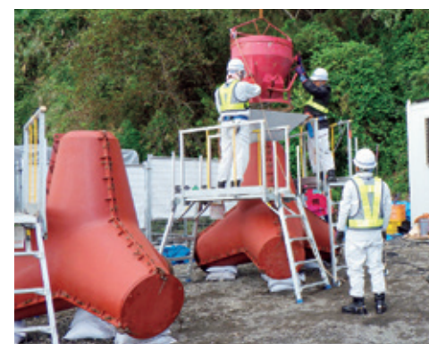
テトラポッドの型枠への打ち込み
