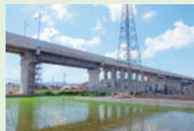
北陸新幹線、福井大町高架橋
