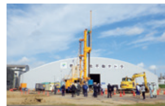
実際の施工機を用いた実験状況
