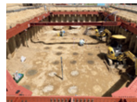
試験土槽内の改良体掘り起こし状況
