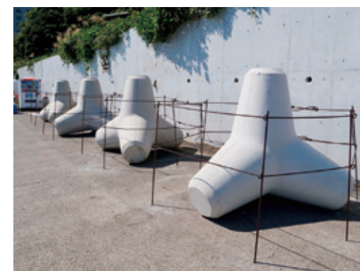
熱海ビーチライン沿岸に設置した「CUCO®-SUICOMテトラポッド」
