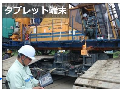
操作室と同じ画面をタブレット端末に表示できるため、施工状況の共有・確認が可能
