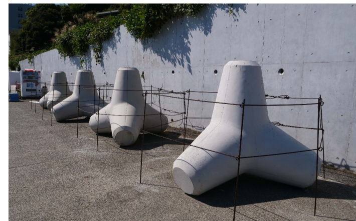
熱海ビーチライン沿岸に設置したCUCOテトラ
