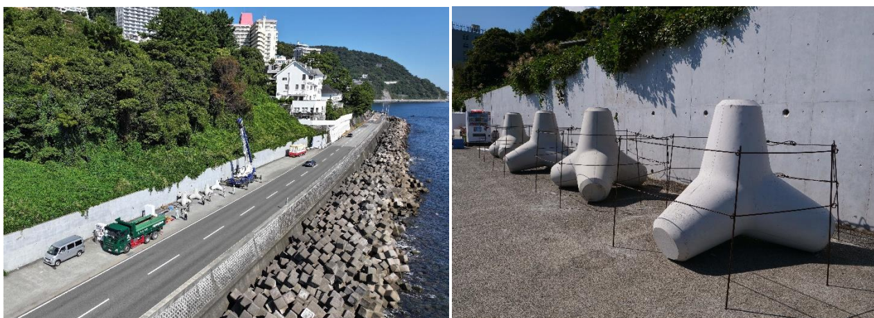
熱海ビーチライン沿岸に設置した CUCO テトラ
