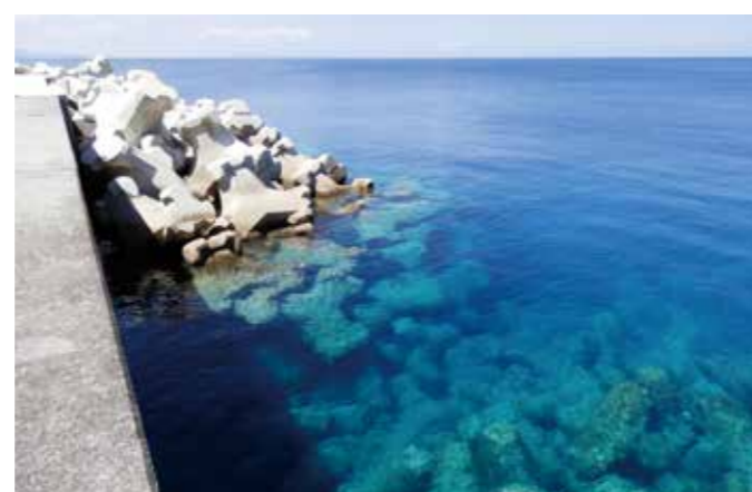
びなま 宜名真漁港(沖縄県) 施工場所:沖縄県国頭村 事業主体:沖縄県 施設の種類:防波堤 トン型:70t型
