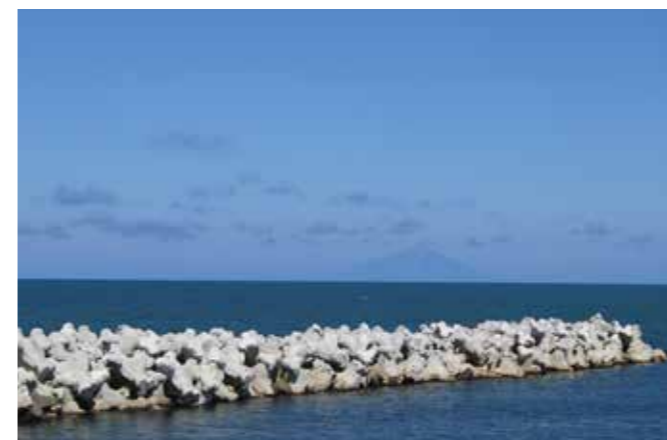
えんべつ 遠別海岸(北海道) 施工場所:北海道遠別町 事業主体:北海道 施設の種類:離岸堤 トン型:12t型
