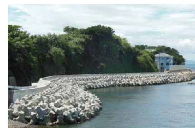
せんしゅう 泉州海岸(大阪府) 施工場所:大阪府岬町 事業主体:大阪府 施設の種類:防潮堤 トン型:4t型
