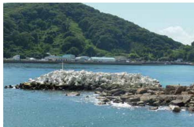
あいおい 相生港(兵庫県) 施工場所:兵庫県相生市 事業主体:兵庫県 施設の種類:防波堤 トン型:4t型
