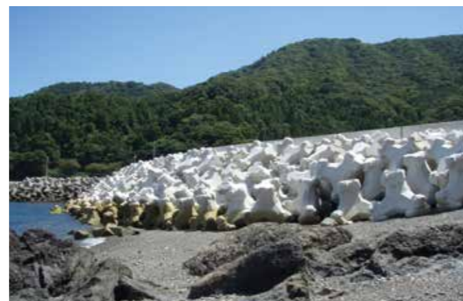
ひがしあかき 東深江漁港(大分県) 施工場所:大分県臼杵市 事業主体:大分県 施設の種類:護岸 トン型:4t型
