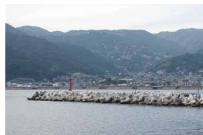
うさみ 宇佐美漁港(静岡県) 施工場所:静岡県伊東市 事業主体:伊東市 施設の種類:防波堤 トン型:20t型
