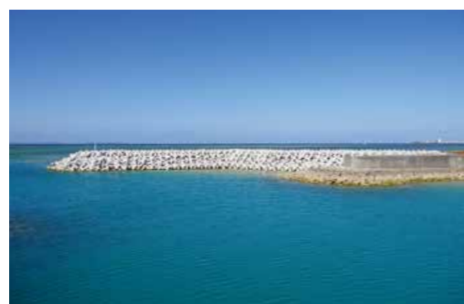
きやん 喜屋武漁港(沖縄県) 施工場所:沖縄県糸満市 事業主体:糸満市 施設の種類:防波堤 トン型:2t型
