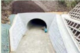
平成31年度 設案ダム瀬戸設案線5号トンネル工事
