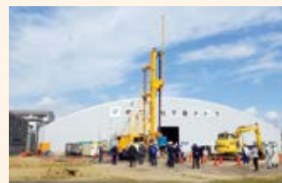
実際の施工機を用いた実験の様子 (高圧噴射系)
