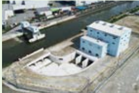
松村川排水機場建設工事(土木・建築)
