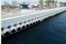
金沢(福浦B)地区水際線護岸災害復旧工事(その9・被覆工)(その10・被覆工)
