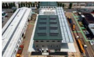
東京機械センター 太陽光発電設備
