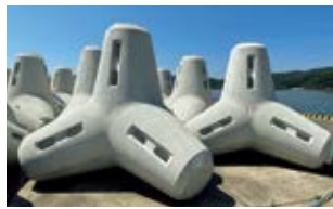
イオンカルチャープレートを貼り付けた溝付きテトラポッド
