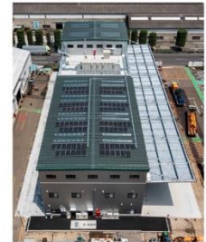
第1工場 (太陽光パネル等)
