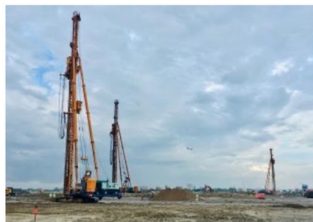
液状化対策として採用されたサンドコンパクションパイル工法（バングラデシュ/2017年）
