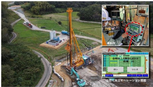
東関東地区での施工状況
