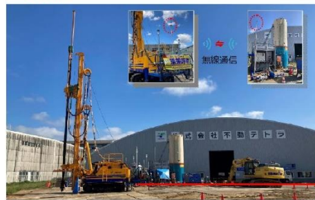
GeoPilot®-AutoPile 小型施工機タイプ
