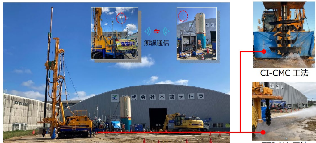
GeoPilot®-AutoPile 小型施工機タイプ
