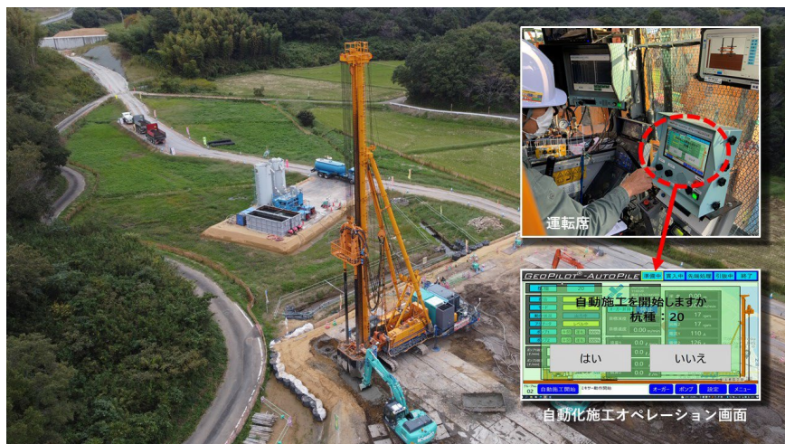
東関東地区での施工状況
