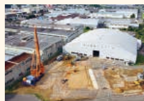
実際の施工機を用いた実験状況
