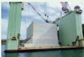
細島港(外港地区)防波堤(南沖) ケーソン製作工事
