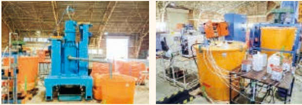
除去土壌の減容化技術の開発(高性能固液分離機による分級処理)
