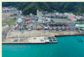
平成30年度名瀬港(本港地区) 岸壁(-7.5m)(改良)工事(第3次)
