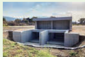
限上川長野伏せ越し改築工事
