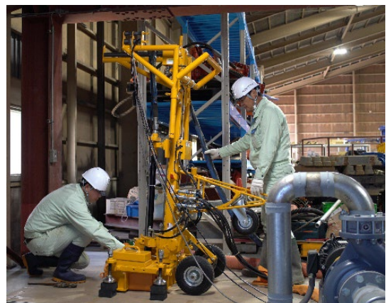
建屋内高さ制限下での施工
