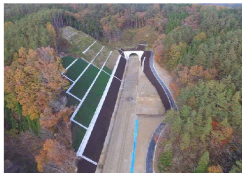
国道45号近内地区道路工事
