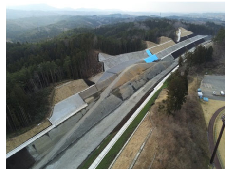
国道45号野田地区道路改良工事
