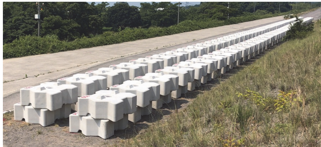
クラブロックS型施工実績 (九州地方整備局 雲仙復興事務所 水無川土砂掘削運搬外工事)
