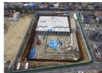
施工状況空撮
