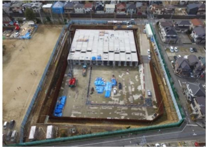
施工状況空撮
