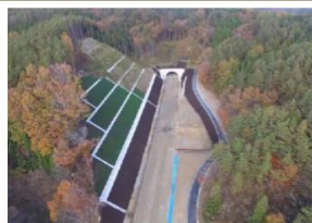
国道45号近内地区道路工事
