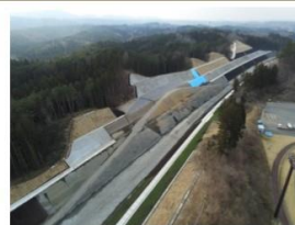
国道45号野田地区道路改良工事
