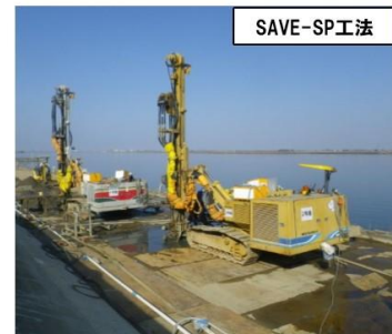
令和元年度木曽川赤地川表高潮堤防補強工事 事業主体:国土交通省中部地方整備局 (元請会社:株式会社新井組)
