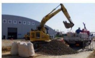
バイオマス混合材料製造状況
