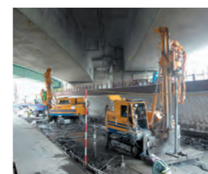
超小型施工機械： 高圧噴射攪拌工法
