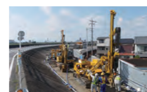
超小型施工機械：SAVE-SP 工法
