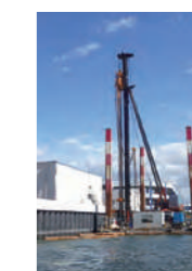
台船式水上施工機械： CI-CMC 工法
