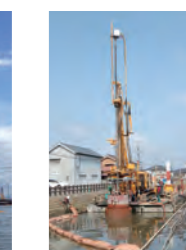
台船式水上施工機械： FTJ-NA 工法
