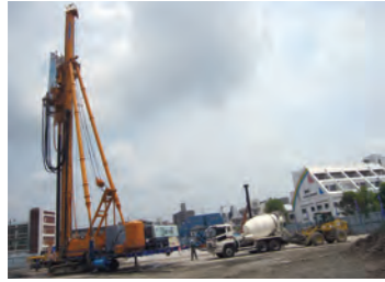
HCP工法 施工状況
