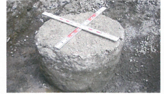
SCP杭の打設状況
