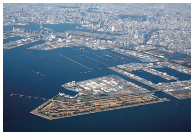
■15号地護岸止水工事(東京都) 39,013m 2 (ℓ=18.5~25m t=4.5mm)
