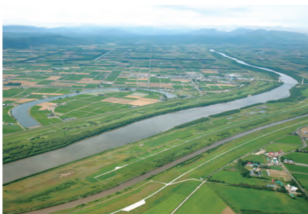
■石狩川改修工事(北海道開発局) 175,572m 2 (ℓ=4~14m t=4.5mm)
