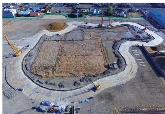
■新たな森建設工事(埼玉県) 7,180m 2 (ℓ=12.1~13.4m t=2.7mm)
