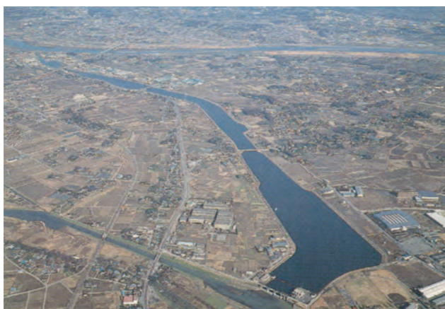
■権現堂調節池遮水壁工事(埼玉県) 187,280m 2 (ℓ=8.5~25.5m t=2.7~4.0mm)
