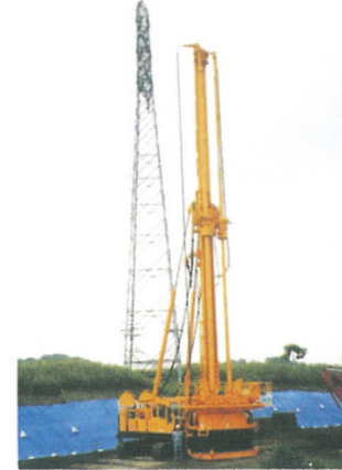
高圧線下施工
