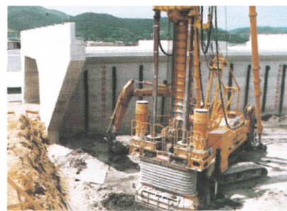
橋台背面基礎の補強 (DJM2070)
