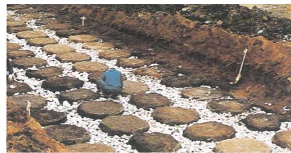
DJM改良柱体頭部 (φ1m) (杭状施工) DJM columns'head in shallow excavation
