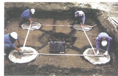
HL-DJM (高強度・低改良率杭施工)
