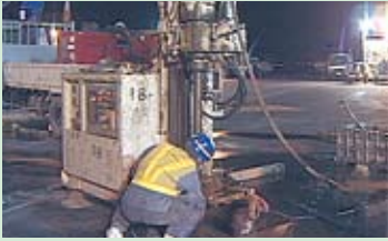
削孔スライムもすべて回収
