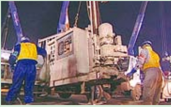
マーキング位置にボーリングマシンをセット
