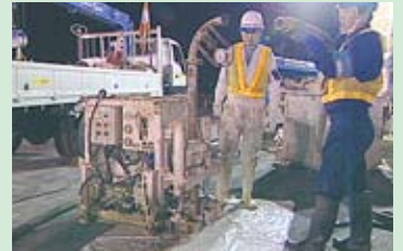
コンパクトな注入管リフト装置
