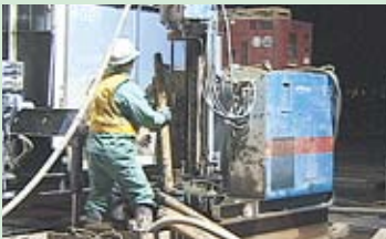
ロッドを継ぎ足して所定の深度まで削孔
