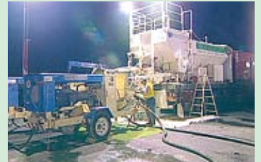
低流動性モルタルを圧送する強力なCPGポンプ
