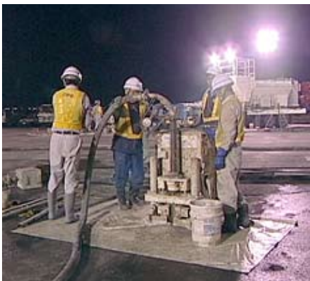
● 地中構造物 液状化層の改良で浮き上がり・傾きを防止
