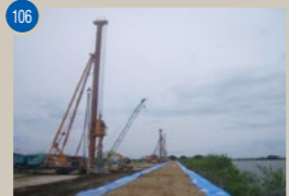
106 H23余郷入堤防災害復旧工事 【工期】2012/3~2012/5
