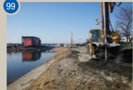
99 災害復旧工事(23災第4号) 【工期】2011/12~2012/3
