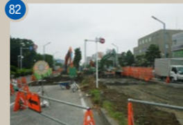
82 市道幹線9号道路災害復旧工事(23災道第68号)及び復興交付金工事(その2) 【工期】2013/5~2013/12
