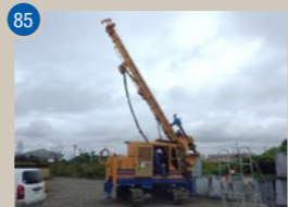
85 H25復興液状化対策第3工区工事 【工期】2015/11~2015/11
