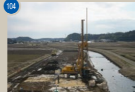
104 県単河川改良工事(地盤改良工) 【工期】2012/2~2012/3
