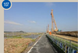
107 H23井関堤防災害復旧工事 【工期】2012/4~2012/5
