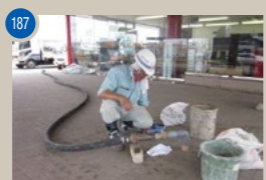
187 神栖地区店舗改修工事 【工期】2011/7~2011/8
