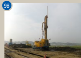
96 県単河川改良工事(3号橋盛土工) 【工期】2011/9~2011/10
