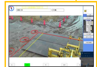
ガイドラインに沿って鉄板を敷き並べている状況
