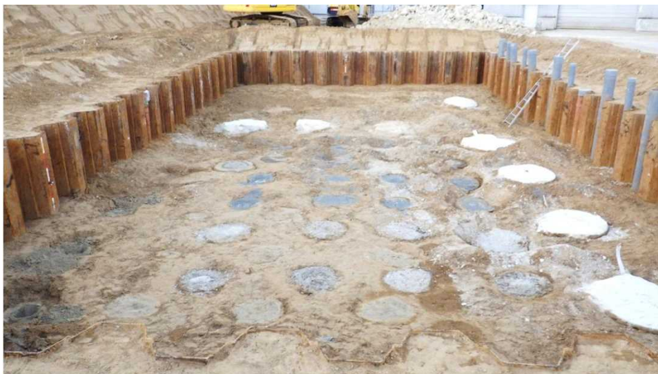
試験中の改良体
