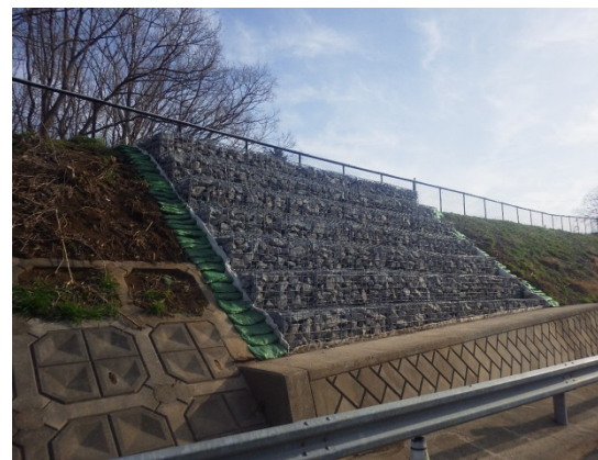
復旧工事完了後
