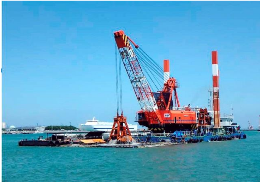
工事名称：平成29-30年度新町川橋浚渫工事 事業主体：国土交通省四国地方整備局 施工場所：徳島県徳島市
