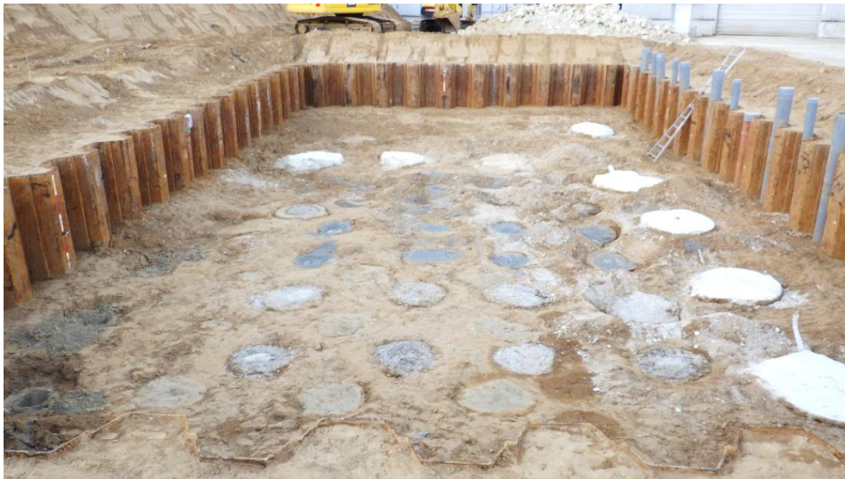
試験中の改良体
