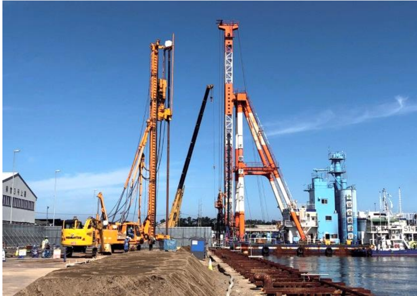
工事名称：金沢港（南地区）岸壁（-7.5m）（改良）築造工事 （その3）の内、海上地盤改良工（深層混合処理） 事業主体：国土交通省北陸地方整備局 （元請会社：五洋・みらい特定建設工事共同企業体） 施工場所：石川県金沢市
