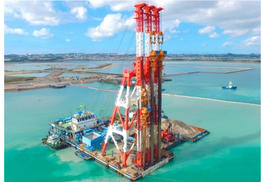
工事名称：中城湾港（泡瀬地区）地盤改良工事（H30-1） 事業主体：沖縄県 （元請会社：(株)屋部土建・(株)美善建設特定建設工事共同企業体） 施工場所：沖縄県沖縄市
