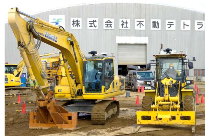
補助作業用重機（バックホー、タイヤショベル）
