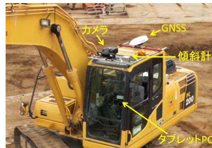
AR装置の設置状況（敷鉄板用バックホー）
