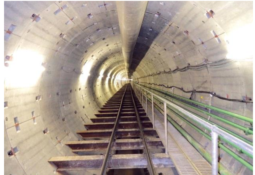
工事名称：ほのか雨水幹線下水道築造工事 事業主体：名古屋市上下水道局 施工場所：愛知県名古屋市
