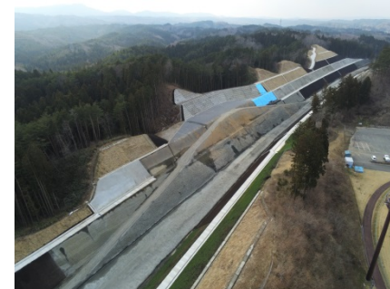
国道45号野田地区道路改良工事
