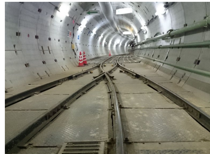
ほのか雨水幹線下水道築造工事 (事業主体:名古屋市)
