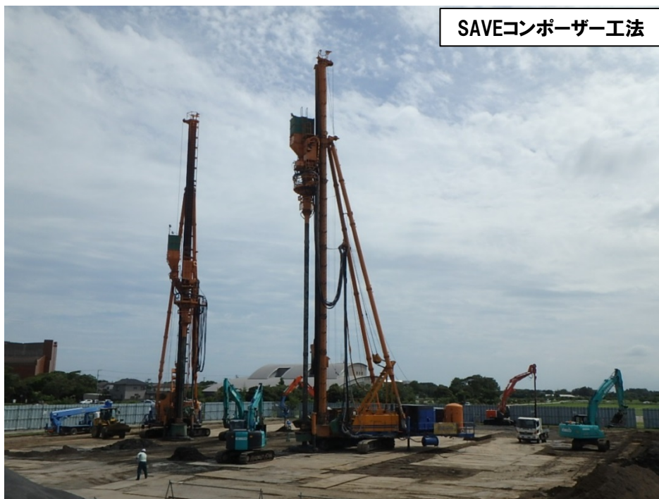
旭市新庁舎建設建築工事 事業主体:旭市(千葉県) (元請会社:奥村・阿部特定工事共同企業体)
