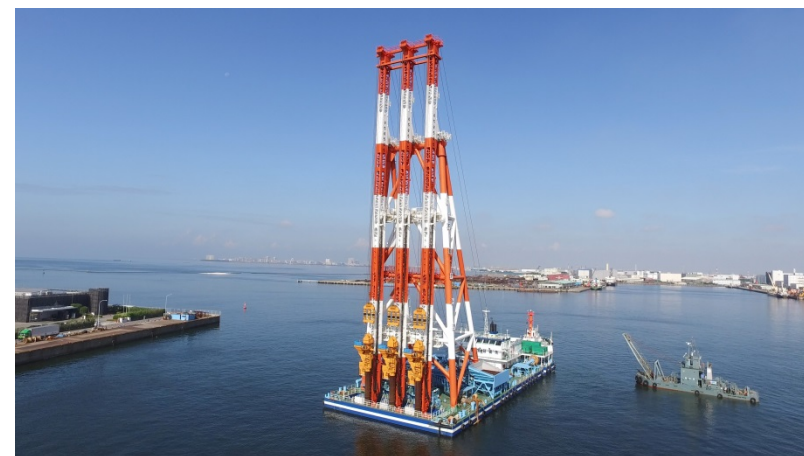
地盤改良船のリフレッシュ (ばいおにあ第30ブドウ丸)
