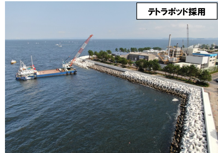
金沢(幸浦・福浦)地区水際線護岸災害復旧工事 事業主体: 横浜市
