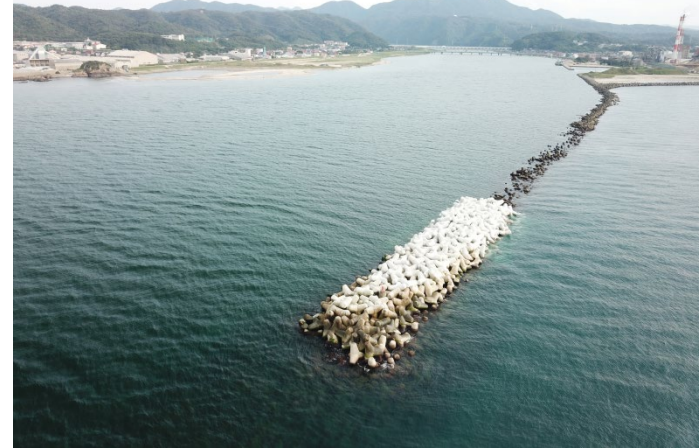
江津港 郷田地区 防災・安全交付金 導流堤改良工事 (老朽化対策(維持嵩上げ工事)) 事業主体: 島根県
