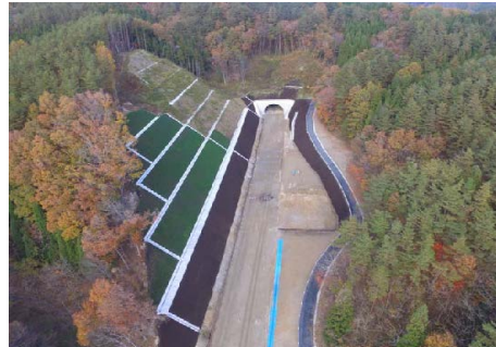
国道45号近内地区道路工事
