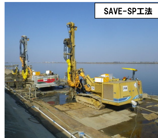
令和元年度木曾川赤地川表高潮堤防補強工事 事業主体:国土交通省中部地方整備局 (元請会社:株式会社新井組)
