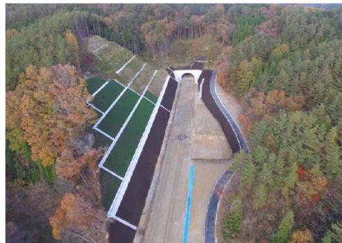
国道45号近内地区道路工事
