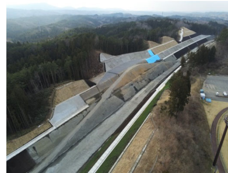
国道45号野田地区道路改良工事
