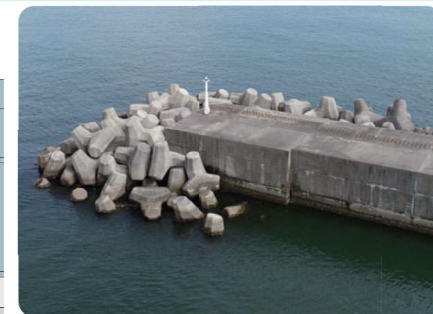
事業主体：国土交通省四国地方整備局 施設名：高知港三里地区防波堤(東第一)(堤頭部) 施工年度：平成24年度～ トン型：100t型
