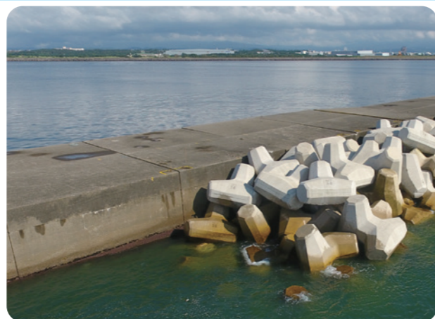
事業主体：国土交通省北陸地方整備局 施設名：金沢港 大野西防波堤 施工年度：平成28年度～ トン型：65t型
