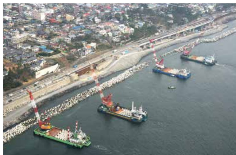
西湘バイパス(神奈川県) 事業主体: 中日本高速道路(株) 施設名: 道路護岸
