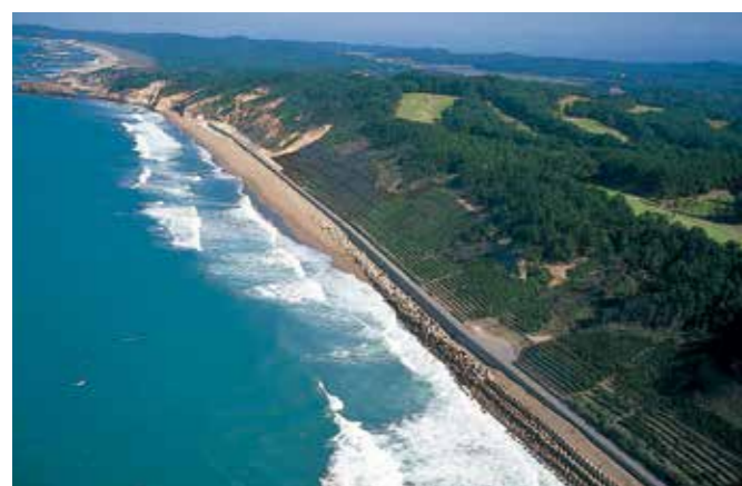
浜坂海岸防災林(福井県) 事業主体:福井県 施設名:護岸 備考:林野海岸
