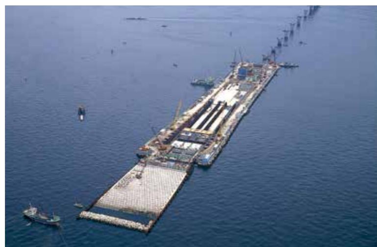
東京湾横断道路 木更津人工島(千葉県) 事業主体: 東京湾横断道路(株) 施設名: 木更津人工島(海ほたる)
