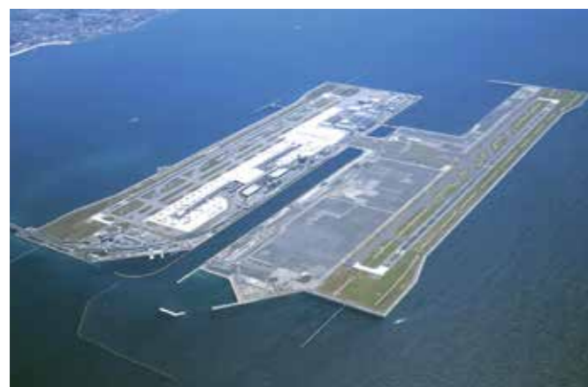
関西国際空港(大阪府) 事業主体:関西国際空港(株) 施設名:空港護岸 備考:緩傾斜石積みによる生物協調型
