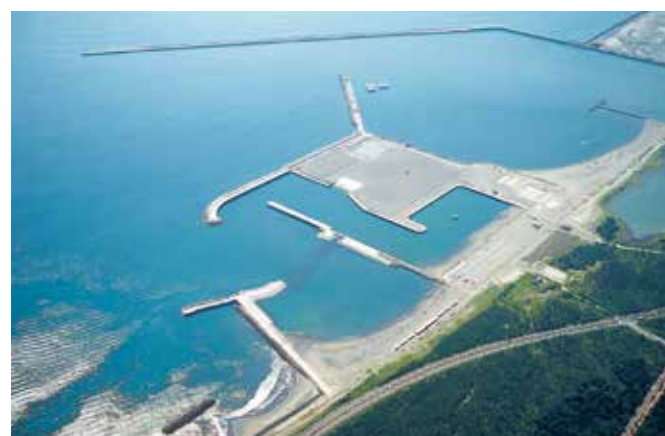
宮崎港(宮崎県) 事業主体:国土交通省九州地方整備局 施設名:南防波堤 マリーナ地区防波堤
