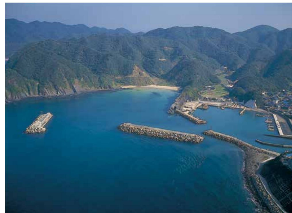
阿連漁港(長崎県) 事業主体:長崎県対馬市 施設名:A防波堤
