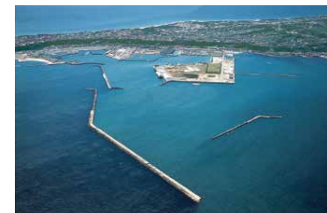
御前崎港(静岡県) 事業主体: 国土交通省中部地方整備局 施設名: 沖防波堤
