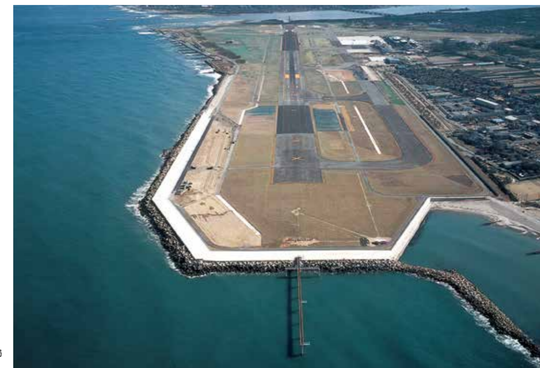
新潟空港(新潟県) 事業主体: 国土交通省北陸地方整備局 施設名: 空港拡張護岸
