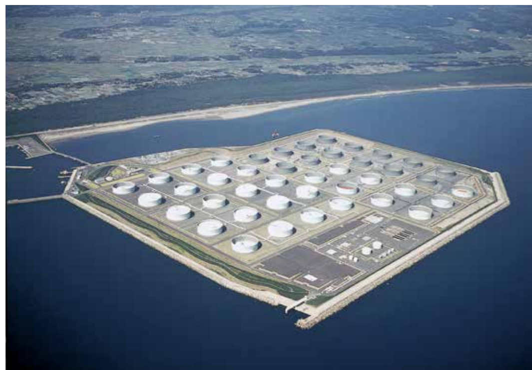
志布志石油備蓄基地(鹿児島県) 事業主体: 志布志石油備蓄(株) 施設名: 埋立護岸
