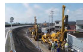
超小型施工機械：SAVE-SP 工法
