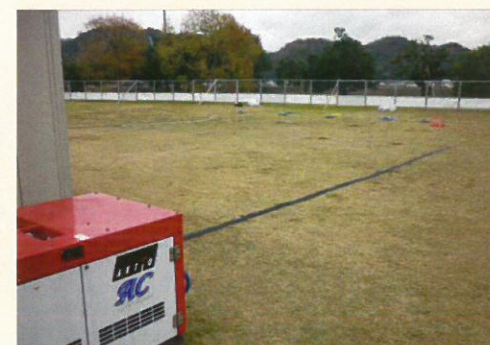
大掛かりな資機材等は不要なため、現場内は整然とした状況です。
