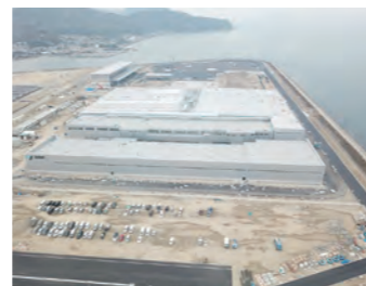
写真提供：株式会社タダノ 新工場建設状況を東から撮影(2019年2月撮影)
