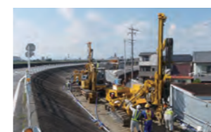
超小型施工機械：SAVE-SP 工法
