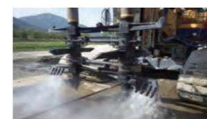
CI-CMC 工法：エジェクター吐出と攪拌翼
