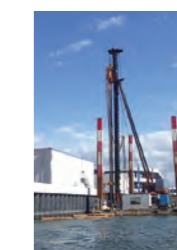
台船式水上施工機械： CI-CMC 工法
