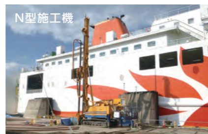
FTJ-FAN工法 高圧噴射攪拌工 (二重管工法)
