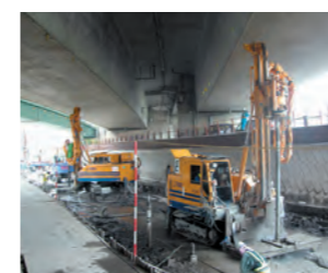
超小型施工機械： 高圧噴射攪拌工法
