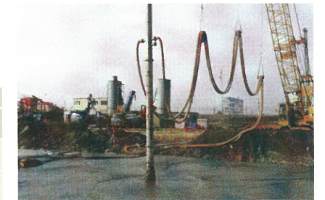
気泡混合処理土の打設状況
