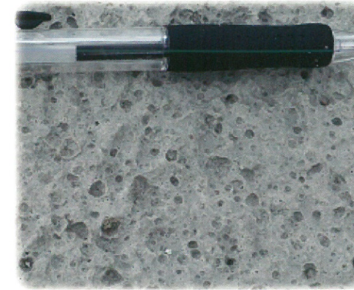
気泡混合処理土
