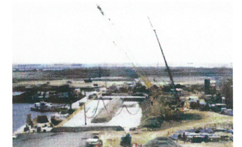
気泡混合処理土の打設状況全景
