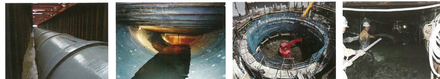
⑨ 大口径管無人化埋戻 ⑩ シールドインバート埋戻 ⑪ オープンケイソン遮水壁構築 ⑫ RC 躯体天端外防水試験
