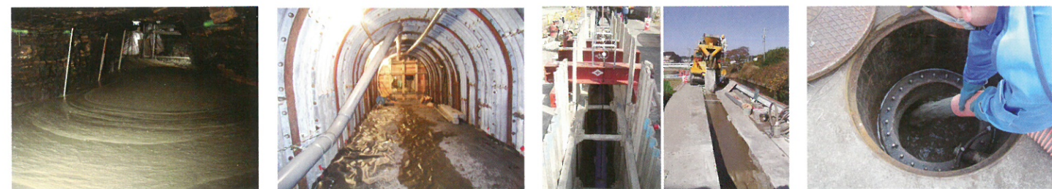
⑬ 亜炭廃坑埋戻試験 ⑭ 地滑地帯排水トンネル閉塞 ⑮ 国交省社会実験下水管 ⑯ 都市インフラ廃止管閉塞
