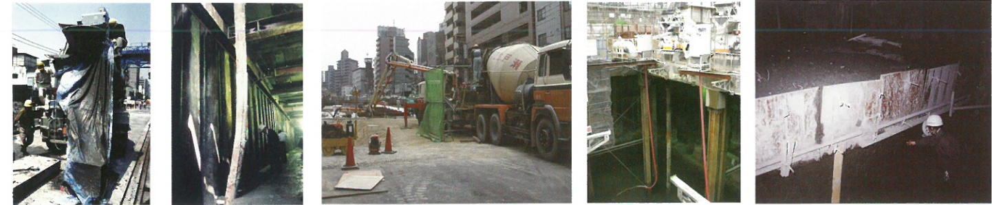
① 共同溝直投へのホッパー打設 ② 共同溝ポンプ圧送打設 ③ 大深度へのシュート打設 ④ 養生3日でのリフト打設
