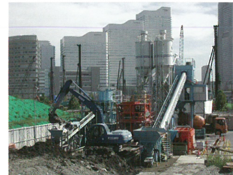
① 大規模仮設プラント
