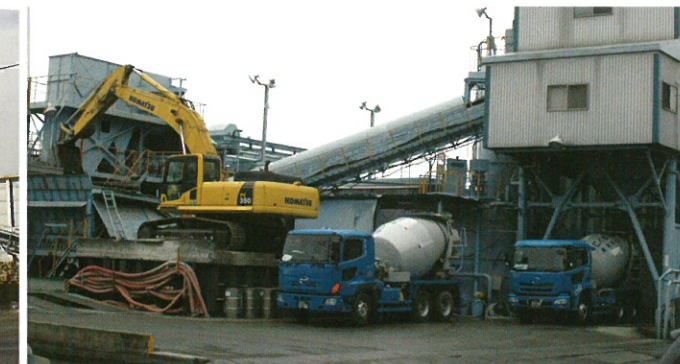
⑤ 都市部常設プラント（その3）
