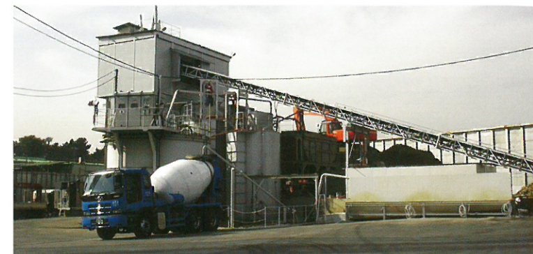
④ 都市部常設プラント（その2）
