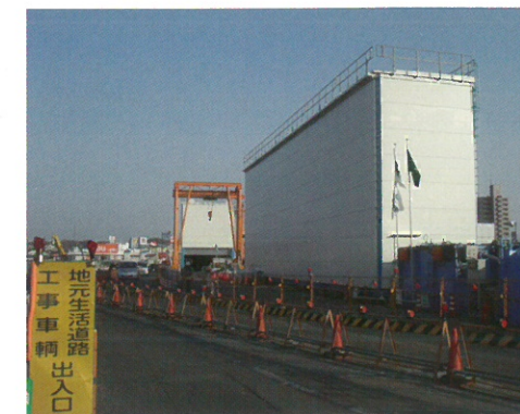
⑨ 道路占有に設置された仮設プラント
