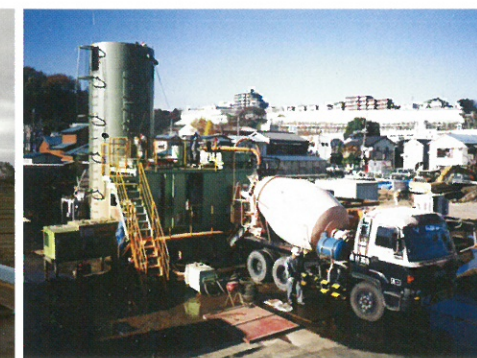
⑦ 市街地中規模仮設プラント
