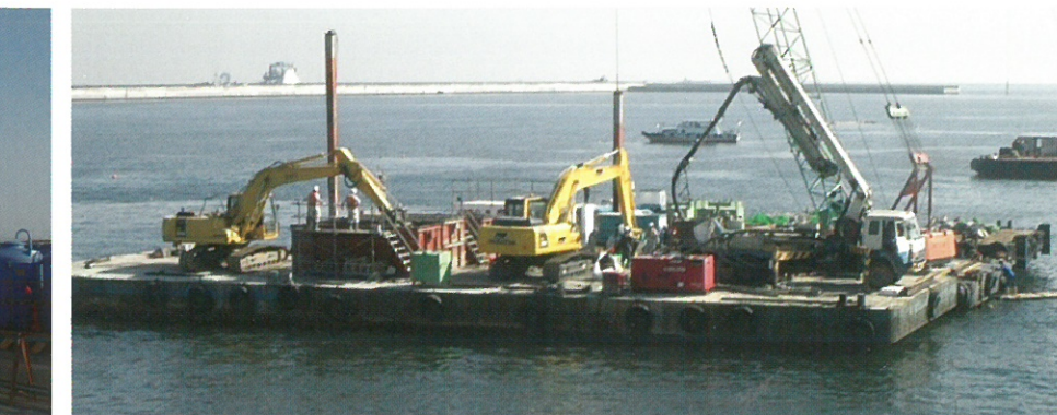
⑩ 海上に設置された仮設プラント
