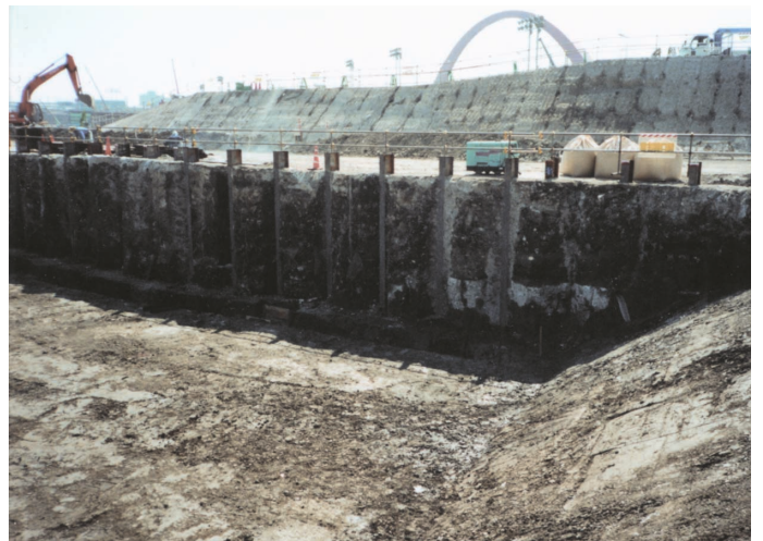
掘削時における自立壁の山留め（東京）
