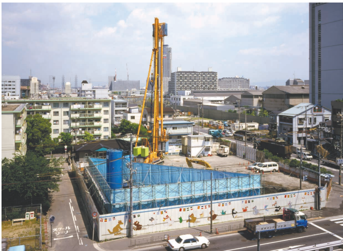
土留め安定対策（大阪）
