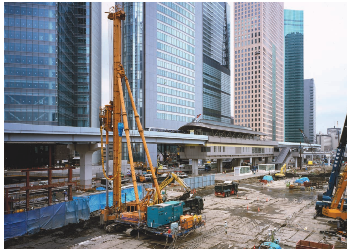
山留め掘削時の地盤変位の抑制（東京）
