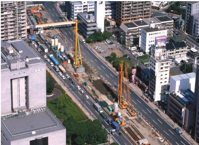
液状化対策及び掘削時の底面安定対策（千葉）
