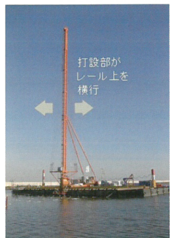
ドレーン打設状況
