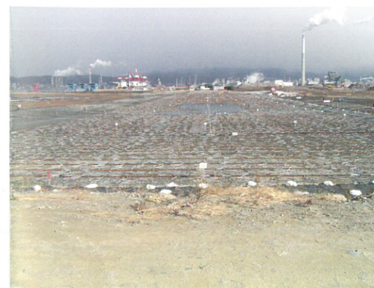
負圧改良(一次)状況
