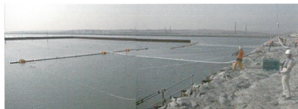
配管設置状況
