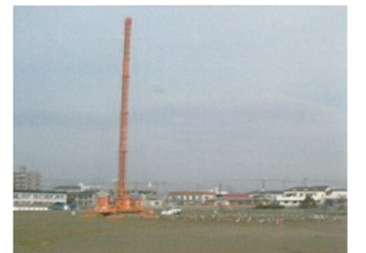
ドレーン打設状況
